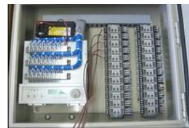
●熱電対変換器を24個、制御盤に組み込んだ例
