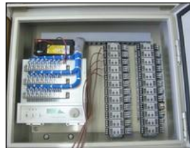
●変換器24個を制御盤に組み込み
