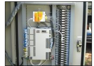
●インターネットを使った、排水路の水位・水温・雨量のネットワーク計測システム例
