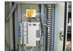
●インターネットを使った、排水路の水位・水温・雨量のネットワーク計測システムの例
