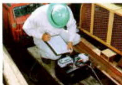
井戸PACK10測定状況
