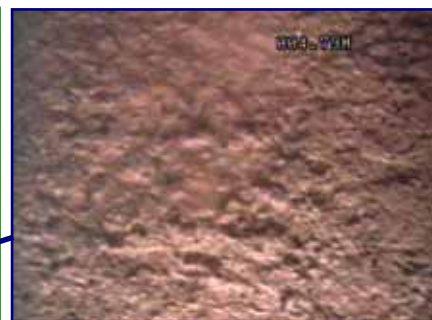
ケーシング内壁状況
