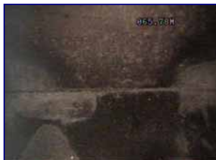
ケーシング接続部状況
