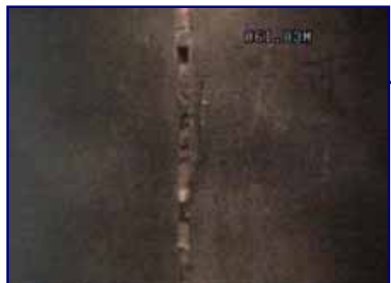
スリット・ストレーナ状況
