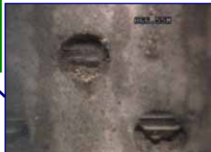
巻き線ストレーナ状況
