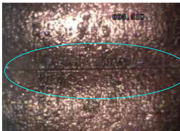
ケーシング管接続部 (3m付近)
