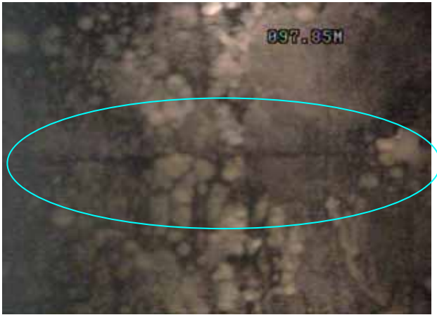
ストレーナ接続部 (97m付近)
