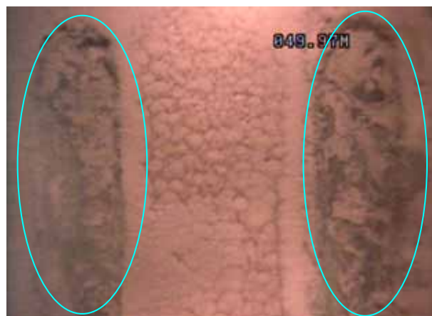
ストレーナ 12閉塞 (49m付近)
