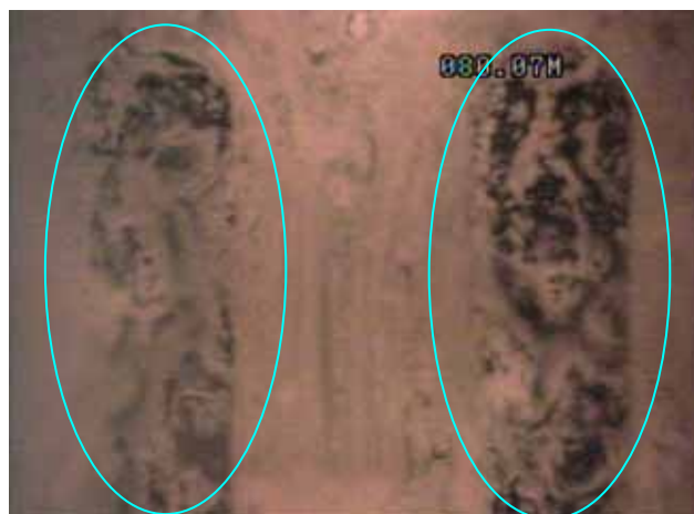
ストレーナ 7閉塞 (80m付近)
