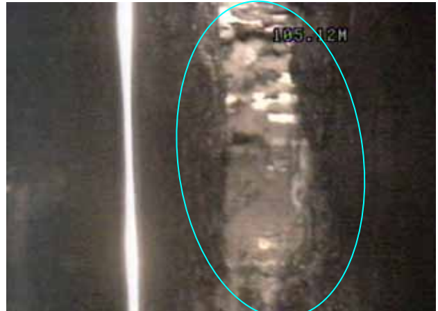
ストレーナ 2腐食孔 (104m付近)
