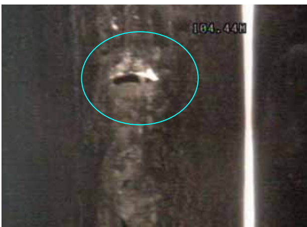
ストレーナ 2腐食孔 (103m付近)
