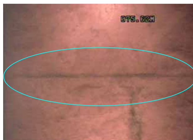
ストレーナ接続部 (75m付近)
