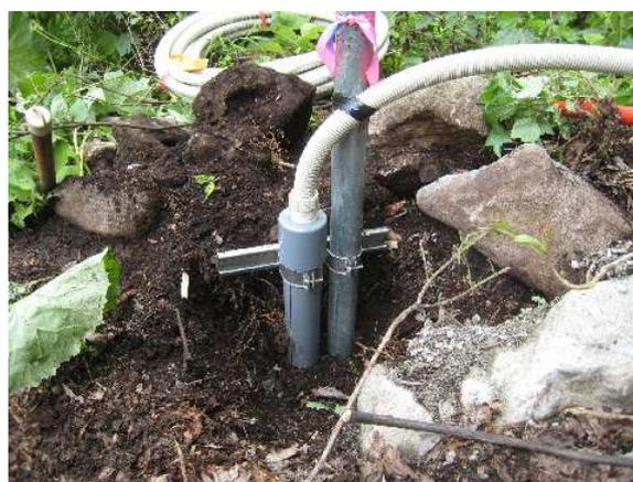
埋設設置 (単管打ち込み) 例
