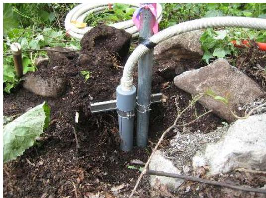
【単管を打ち込みクリップ固定した後に埋設】
