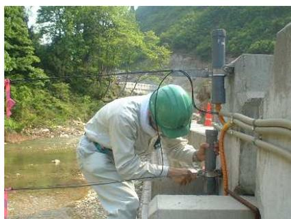
【レールを堰堤にアンカーで固定しクリップ留め】
