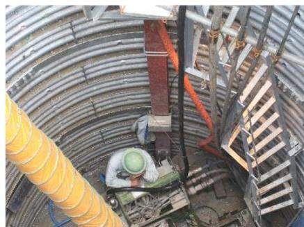
【アルミケースに XY 2 個入れ H 鋼に U ボルト留め】
