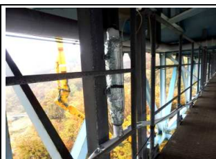
計器とホースを断熱材養生
