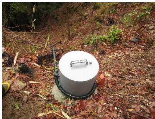
図-4 水位計設置マスと電線管の外観
