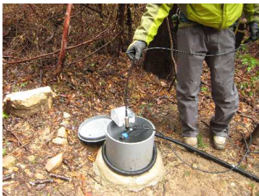
図-3 水位計の挿入状況
