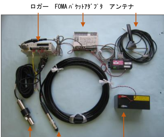
●水位と濁度の Web モニタリング例
