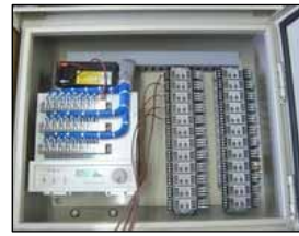
変換器24個を制御盤に組み込み
