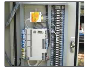
インターネットを使った、排水路の水位・水温・雨量のネットワーク計測システム例
